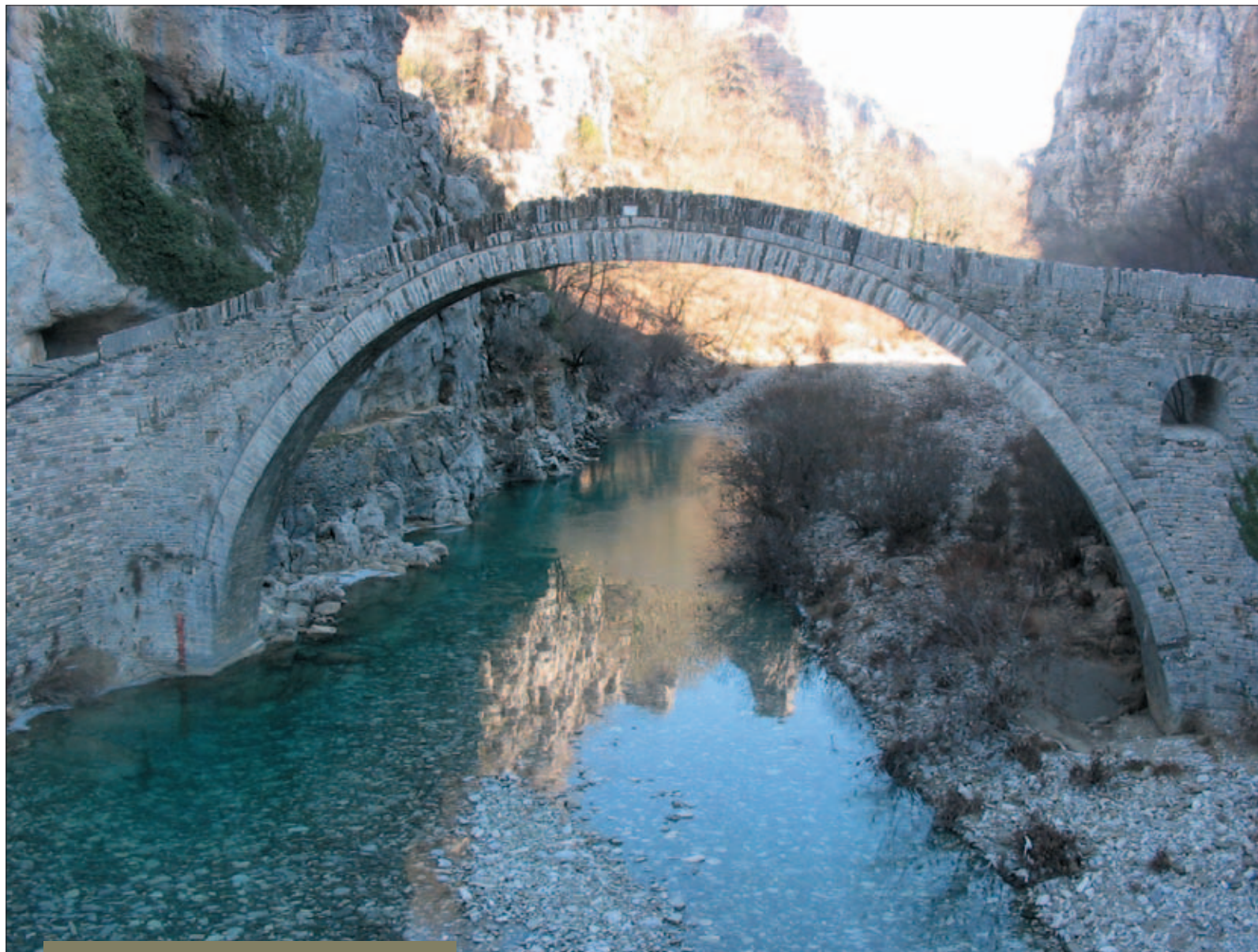
Το γεφύρι του Νούτσου ή Κοκόρου όπως είναι γνωστό, που κατασκευάστηκε το 1750 κατέχει επιβλητική θέση σε μια στενή χαράδρα μεταξύ των χωριών Κήποι και Κουκούλι. (Ευγενική παραχώρηση του ΦΔ Εθνικών Δρυμών Βίκου Αώου και Πίνδου) © Πολιτιστικός Σύλλογος Βραδέτου
